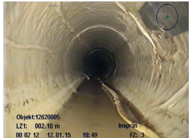
Abb. 5 – Längsfalte in der Sohle und am Umfang
