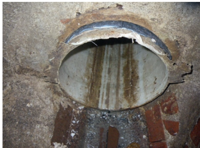
Abb. 3 – Verlängerter Liner DN 250
