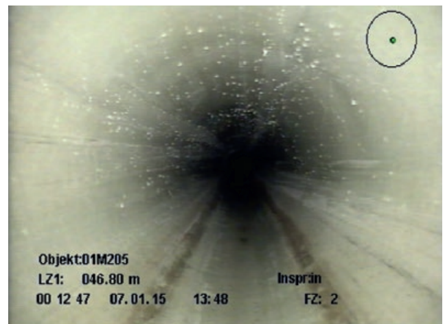
Abb. 5 – Längsfalte in der Sohle und am Umfang
