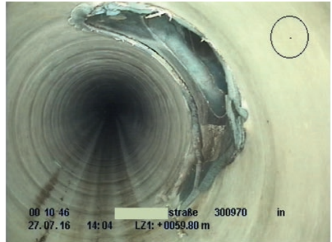
Abb. 9 – Abgerissene EP-Harzanbindung
