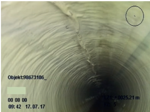
Abb. 4 – Längsfalte im Scheitel
