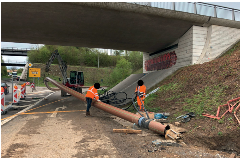
Einzug des PE RC-Rohrstrangs in den Bohrkanal | Foto: Markus Dohmann
