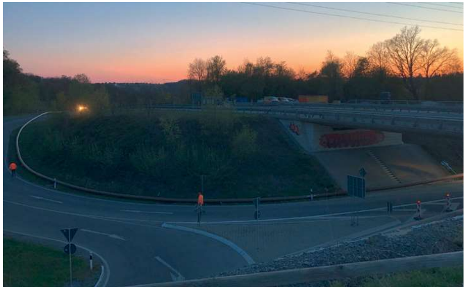
Transport PE RC-Rohrstrang zur Einzugsbaugrube am Böschungsfuß der Bundesstraße B14 | Foto: Markus Dohmann
