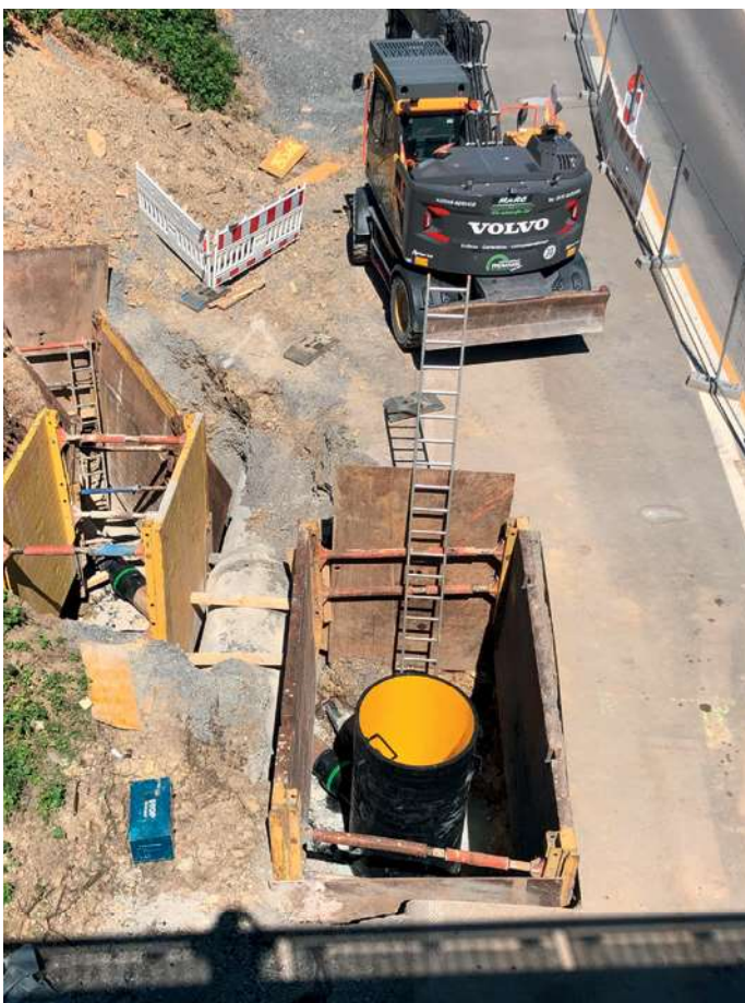
Anbindung Spülbohrstrecke an den Bestand | Foto: Markus Dohmann
