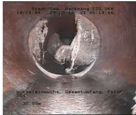
Riss- und Scherbenbildungen sowie massiver Wurzeleinwuchs in den Haltungen | Fotos: Andreas Huber
