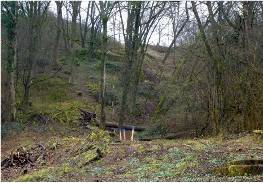
Abgesteckte Bohrtrasse (blaue Pfähle) mit aktuellem Verlauf der Pilotbohrung (rot-weiße Stangen) | Fotos: Markus Dohmann; Andreas Huber
