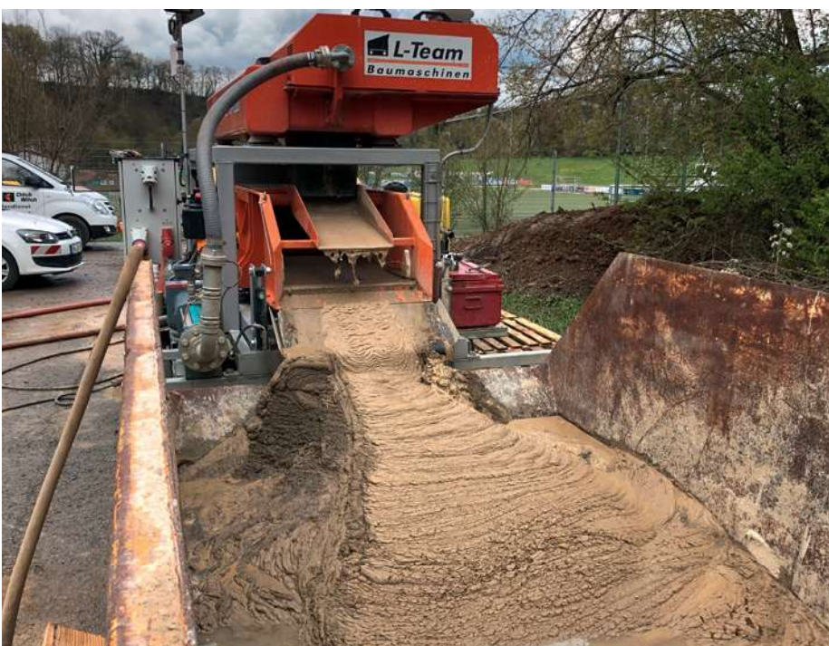
Einsatz der Separationsanlage | Foto: Markus Dohmann
