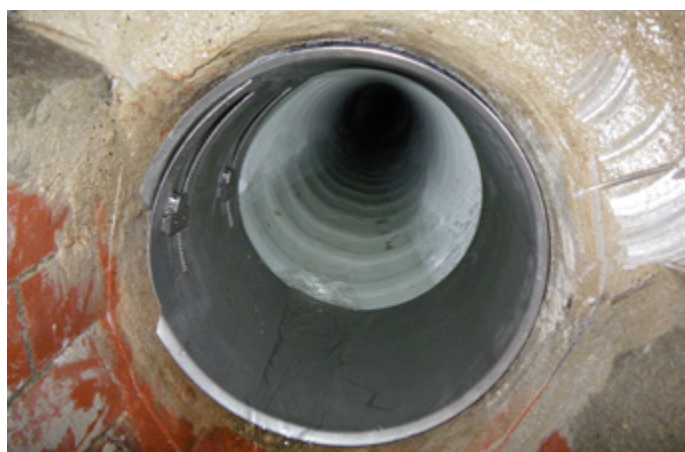
Bild 5: QUICK-LOCK-Linerendmanschette vom Schacht aus
