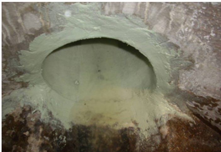
Bild 1: Lineranschluss durch Verspachtelung mit Epoxidharz
