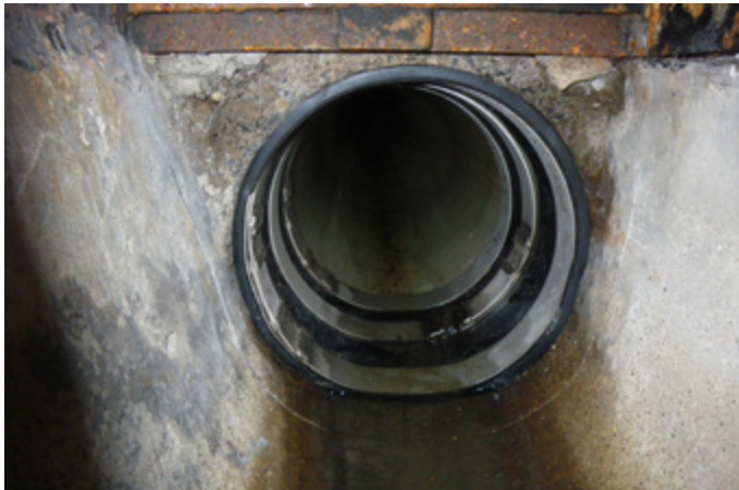
Bild 3: AMEX-Linerendmanschette vom Schacht aus
